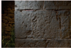
Détail du parement du gros pilier rectangulaire Est. Taille brochée, linéaire oblique et ciselure périmétrique, 15 e s. (photo J.-N. Anslijn © AWaP)
