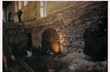
Les arcs de décharges du dortoir des femmes ont, en 1667, épargné les inhumations antérieures tout en renforçant la stabilité du bâtiment posé sur de gros massifs maçonnés (photo Th.Cortembos © AWaP)
