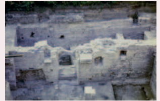
Face intérieure du rempart de l'an mil, percé par les fentes contemporaines aménagées et la porte du cellier. A l'arrière, le second rempart du 13 e s. (photo J.Plumier © AWaP)
