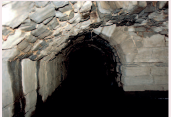
Le grand courrot en pierre encore conservé sous la cour et le dortoir des femmes de l'aile orientale actuelle (photo Th.Cortembos © AWaP)
