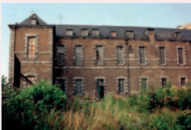
L'aile occidentale du début du 18 e s. avant travaux de restauration (photo Th.Cortembos © AWaP)
