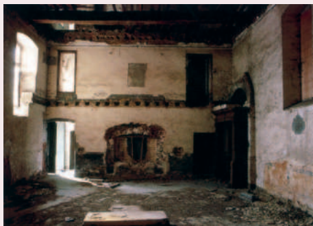
La chapelle Saint-Nicolas avant restauration (photo Th.Cortembos © AWaP)
