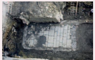
Deux citernes jumelées en briques cimentées, dégagées dans la cour devant l'aile occidentale lors des travaux de terrassements nécessaires pour le chantier de restauration (photo J.Plumier, 1991 © AWaP)
