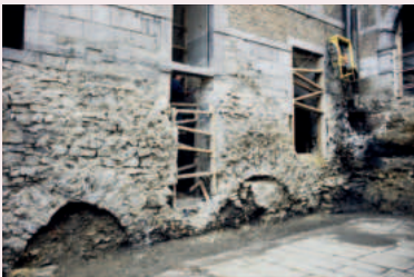
Les fondations de l'aile occidentale ont été lancées, en 1723, sur des arcs de décharge enjambant les vestiges de constructions antérieures (photo J.Plumier, 1991 © AWaP)
