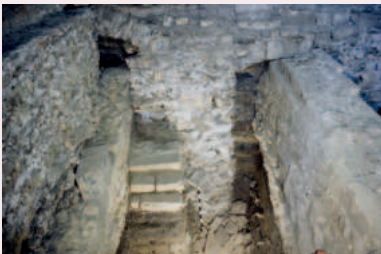
Le petit cellier de la maison Pontillas, situé sous l'entrée de la chapelle Saint-Nicolas, fut remblayé après démolition de ladite maison en 1450 (photo J.Plumier, 1990 © AWaP)
