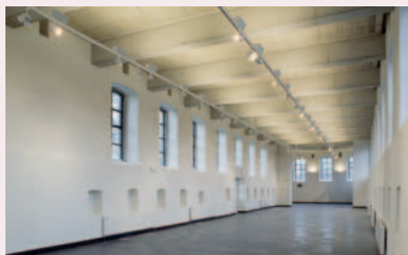
Le dortoir des femmes, rez-de chaussée, après restauration; au fond, la chapelle Saint-Nicolas (photo Th.Cortembos © AWaP)
